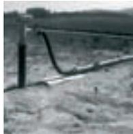
Foto 1: Cabezal de pozo construido post relleno
